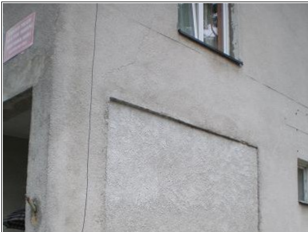
Fot.nr 7: Widok miejsca na elewacji bocznej, w którym powstała rysa zakwalifikowana do wzmocnienia.
